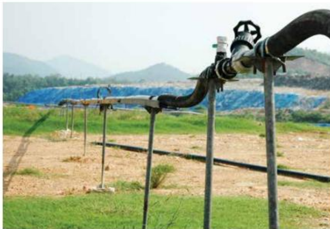
Hệ thống thu khí CDM tại bãi chôn lấp rác Nam Sơn, Đông Anh, Hà Nội.
