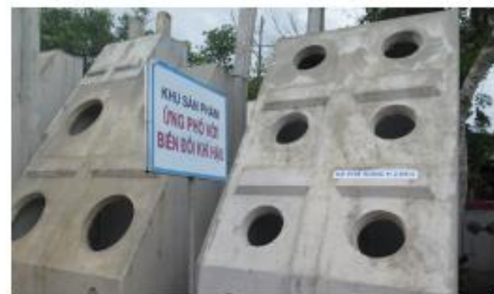
Cấu kiện kê phá sóng lắp ghép từ bê tông thành mỏng của Busadco. Ảnh: NV
