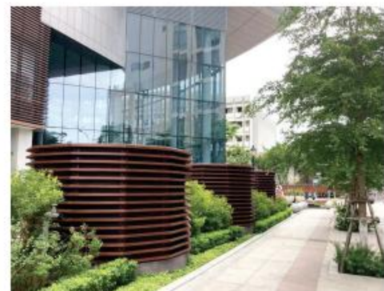
Cửa thông gió tầng hầm của Trung tâm hành chính Đà Nẵng.
