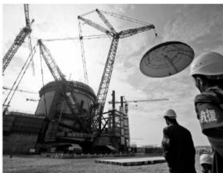
Nhà máy điện hạt nhân Trường Giang đang trong quá trình xây dựng ở tỉnh Hải Nam, Trung Quốc. Ảnh: Guardian
