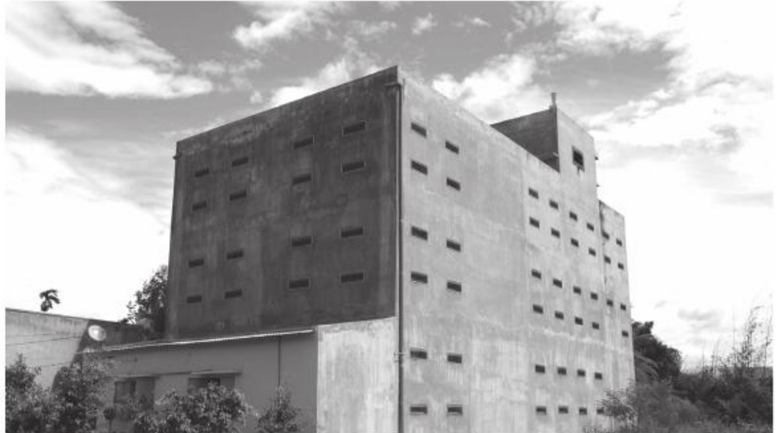
Mô hình nhà yến xây dựng ở nông thôn.
