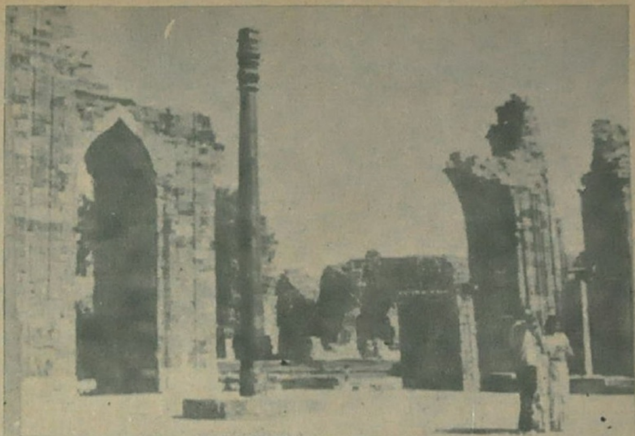
Hình chụp một cây cột trụ bằng sắt chôn tại ngoại ô New-Delhi, được đúc bằng hợp kim không thể rỉ sét lâu tới 1500 năm trước Tây-lịch. Ngày nay chúng ta vẫn không biết cách chế tạo loại hợp kim bền bỉ này.
