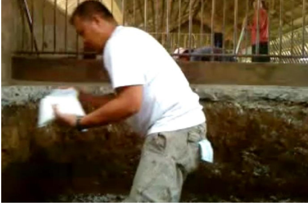
Hình 4.1.4. Đào hố và hỗn hợp đất đỏ và vật liệu hữu cơ
