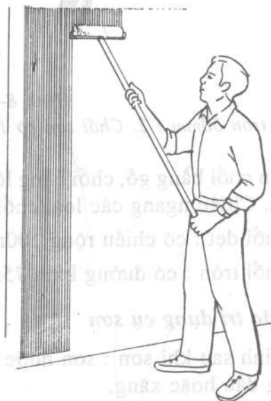
Hình 8-34 : Lăn sơn bề mặt
