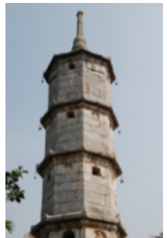
Hình 1. Chùa Bút Tháp (Bắc Ninh).
