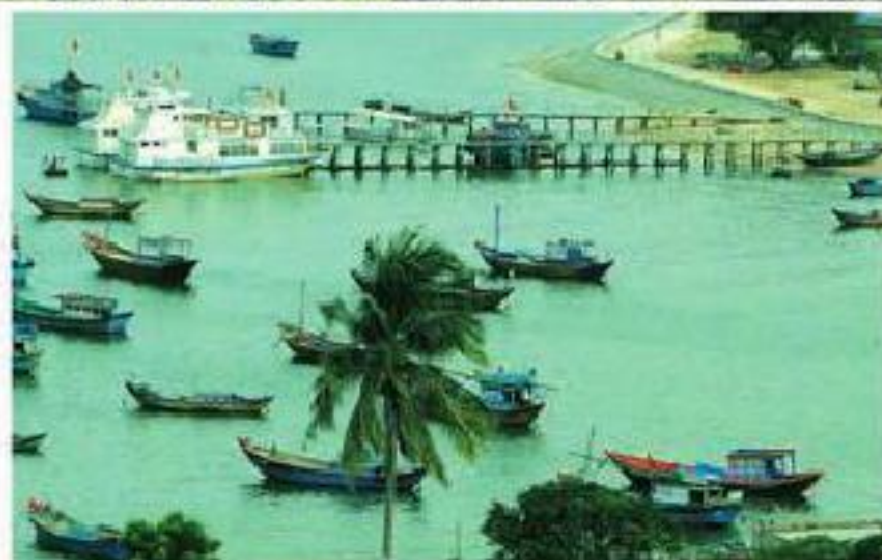
CÁU TÀU MỚI XÂY DỰNG
