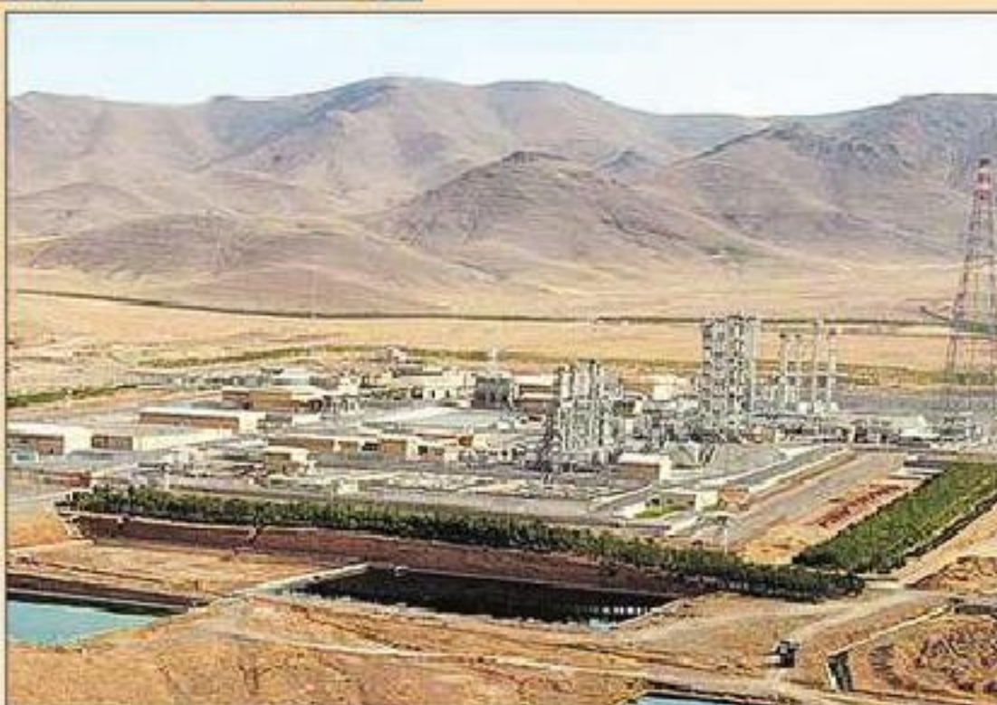
TOÀN CẢNH NHÀ MÁY TÁCH NƯỚC NẶNG Ở ARAK, PHÍA TÂY CỦA IRAN
