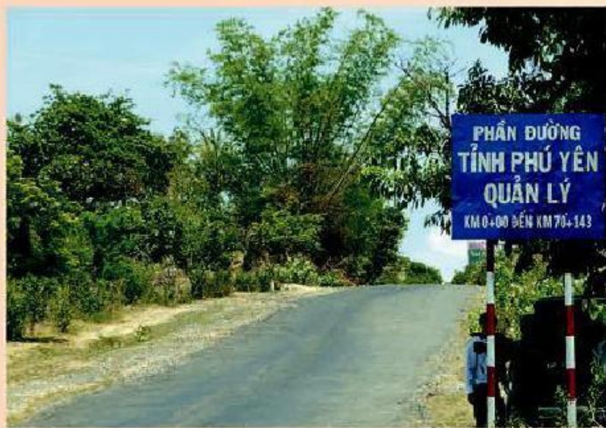
QL25 Ở ĐIỂM ĐẦU ĐỊA PHẬN PHÚ YÊN
