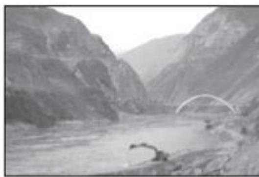
Quang cảnh đập Tiểu Loan đang được xây dựng vào năm 2004
