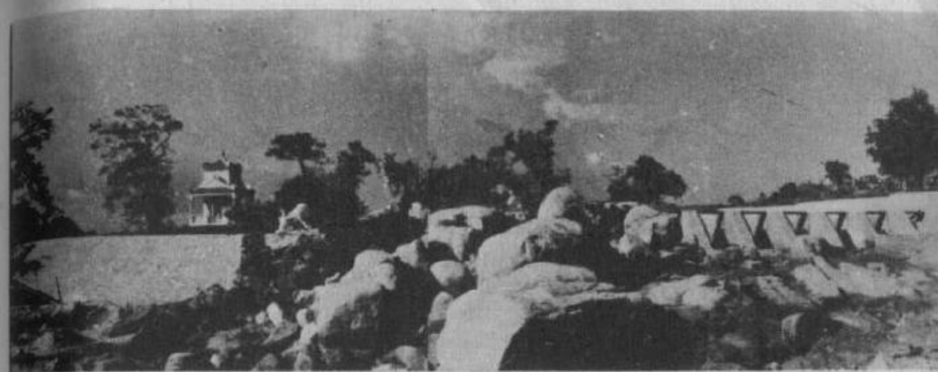
Một công-trình dân-thầy nhập điển : Đập Đá-dựng thuộc tỉnh Bình-tuy
