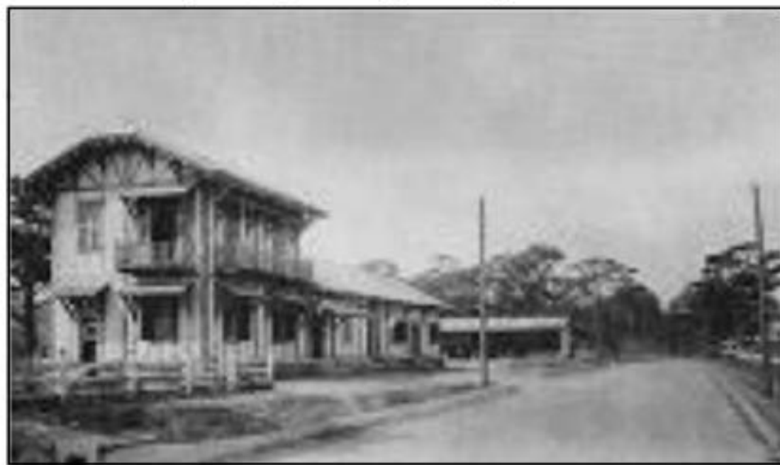
Nhà ga tạm thời
