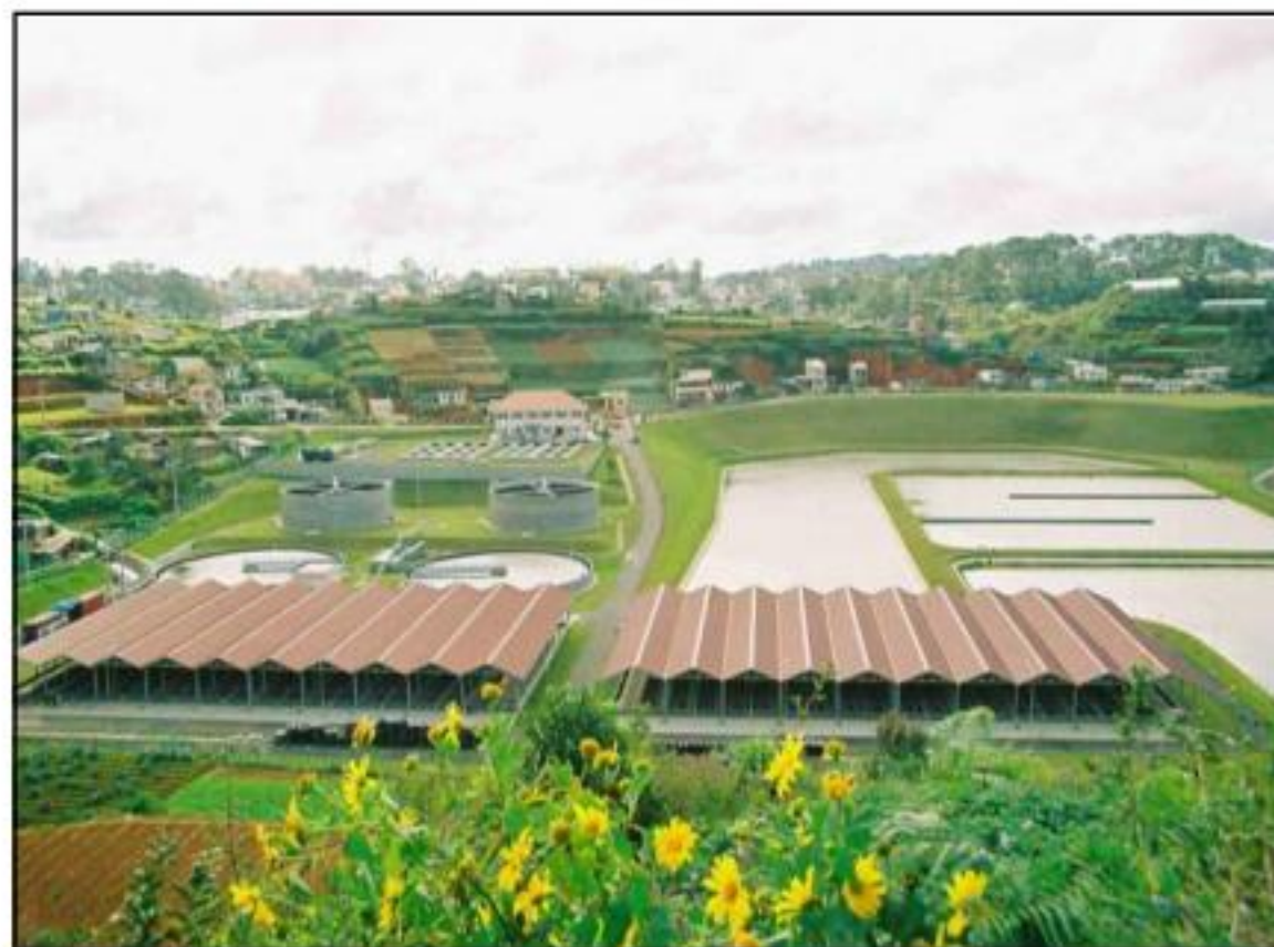
Nhà máy xử lý nước thải tập trung
