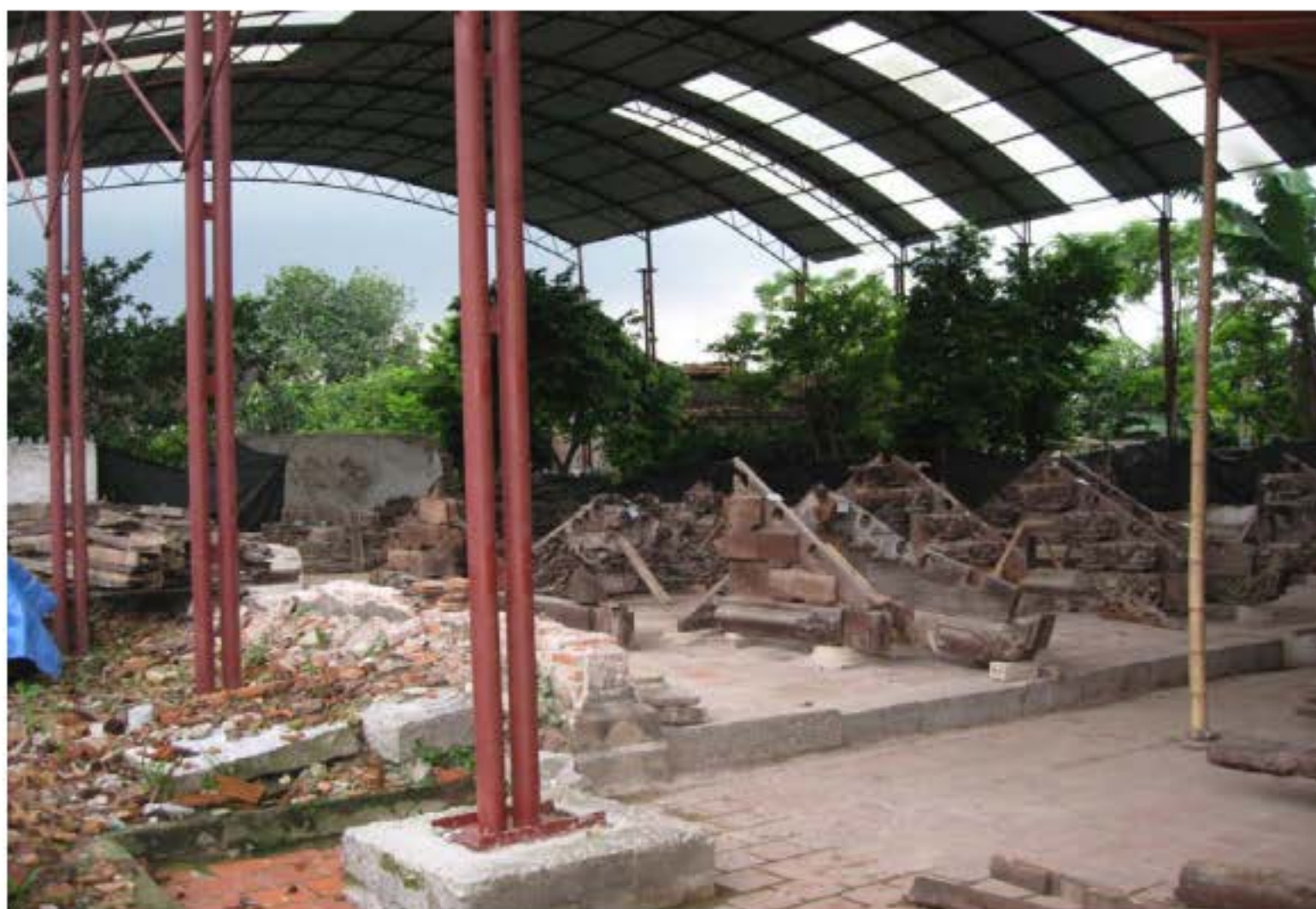
Công trường tu bổ đền Trần Khắc Chân, Thanh Hóa (năm 2012) - Ảnh: Nguyễn Thúc
