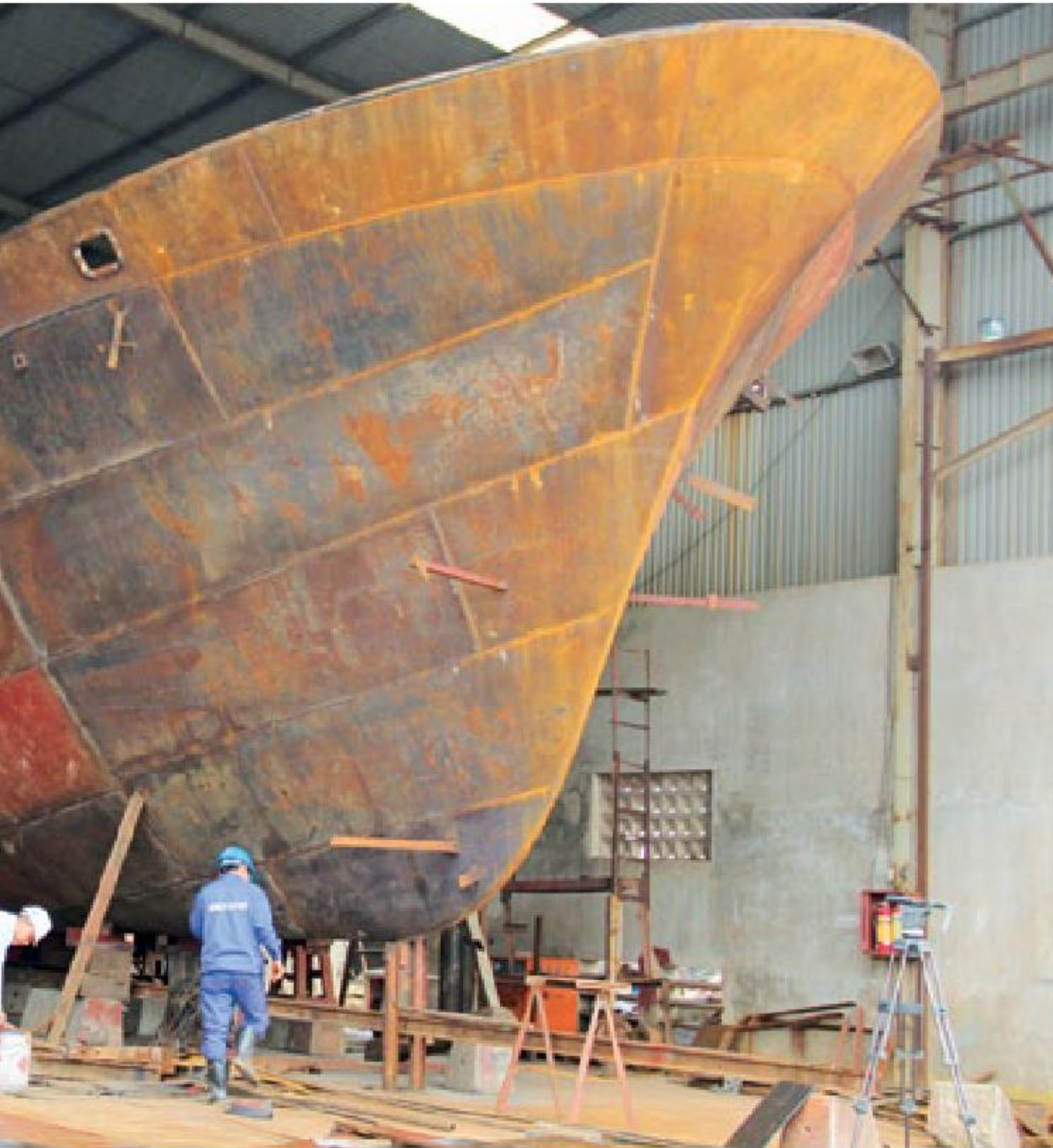
Những con tàu vỏ sắt của ngư dân đang được Nhà máy đóng tàu Nghệ An khẩn trương hoàn thiện
