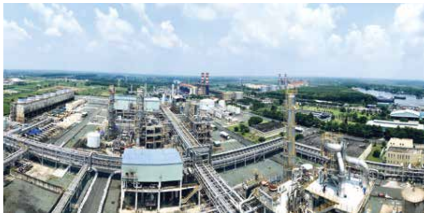
Nhà máy Đạm Cà Mau. Ảnh: PVCFC
