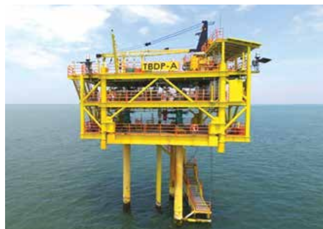
Hình 1. Giàn đầu giếng Thái Bình-A.
