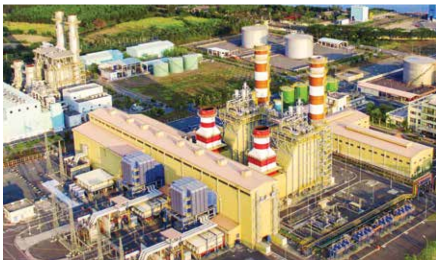
Nhà máy Điện Nhơn Trạch 2. Ảnh: PVN
