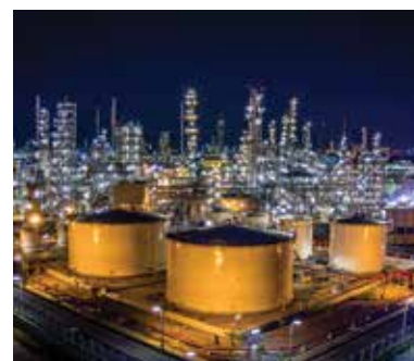
Nhà máy lọc dầu của Saudi Aramco. Nguồn: Emerson
