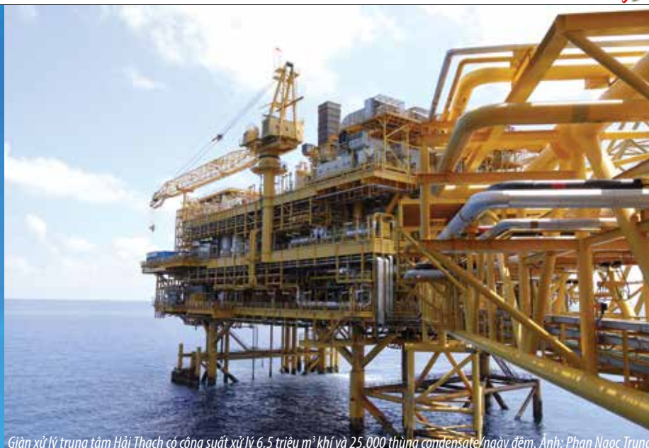
Giàn xử lý trung tâm Hải Thạch có công suất xử lý 6,5 triệu m 3 khí và 25.000 thùng condensate/ngày đêm. Ảnh: Phan Ngọc Trung
