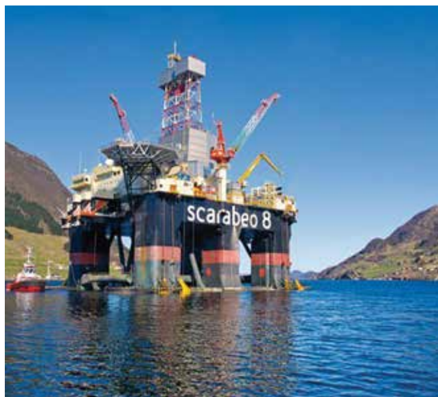
Giàn khoan Scarabeo 8. Nguồn: Saipem
