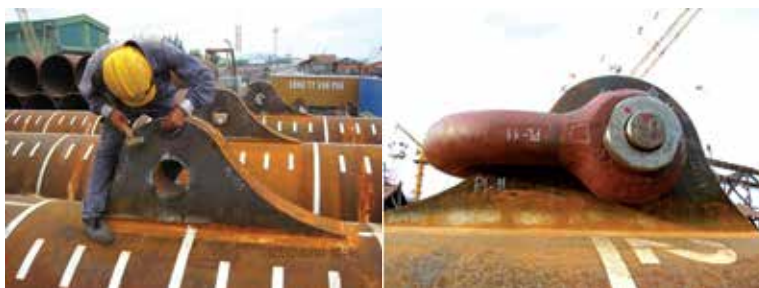
Hình 11. Kiểm tra độ vừa của ma ní vào tai cọc
