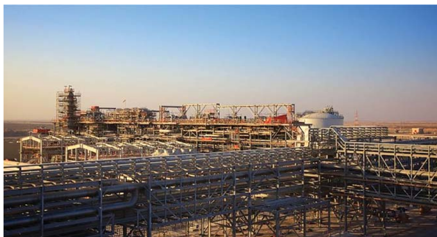
Nhà máy xử lý khí Khazzan. Nguồn: BP PLC
