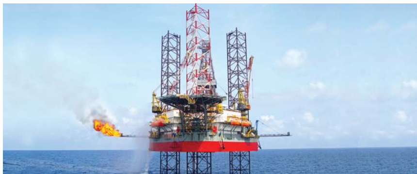
Giàn khoan tự nâng PV Drilling II đạt gần 3 triệu giờ công an toàn. Ảnh: PVN
