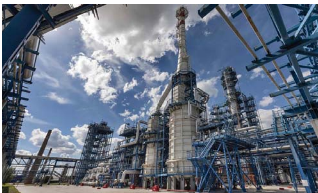
Xưởng sản xuất hydro độc lập có công suất 12.300 tấn hydro có nồng độ tinh khiết cao (99,9%) mỗi năm dự kiến sẽ được đưa vào hoạt động vào cuối năm 2017.
