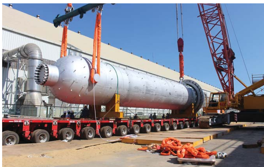
Các thiết bị siêu trường siêu trọng được PVFCCo lắp đặt thành công. Ảnh: PVFCCo
