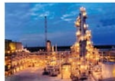
Nhà máy Đạm Cà Mau. Ảnh: PVCFC
