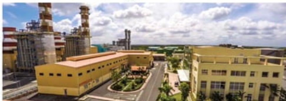
Nhà máy Điện Nhơn Trạch 2. Ảnh: PVN
