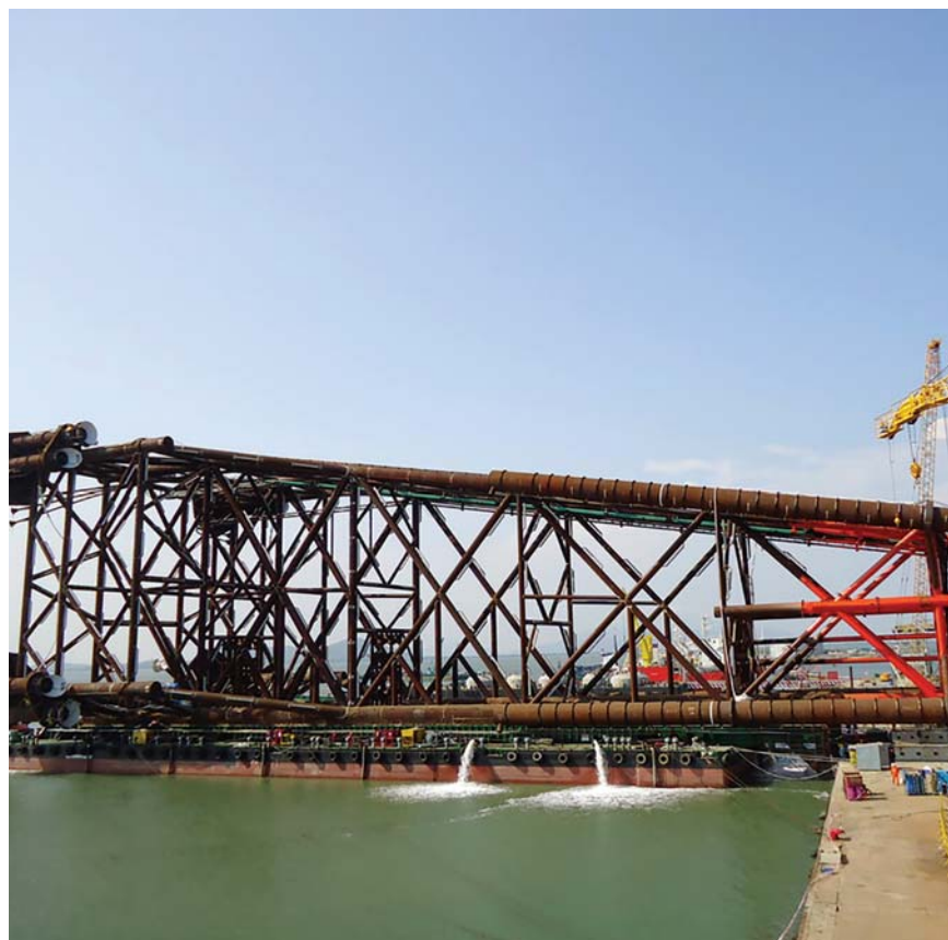
Chân đế giàn DH2 được vận chuyển và hạ thủy bằng sà lan chuyên dụng. Ảnh: VSP
