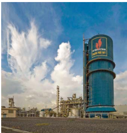
Nhà máy Đạm Phú Mỹ. Ảnh: PVFCCo
