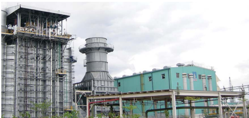
Nhà máy Điện Nhơn Trạch 1. Ảnh: PVN
