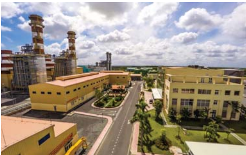
Nhà máy Điện Nhơn Trạch 2. Ảnh: PV Power
