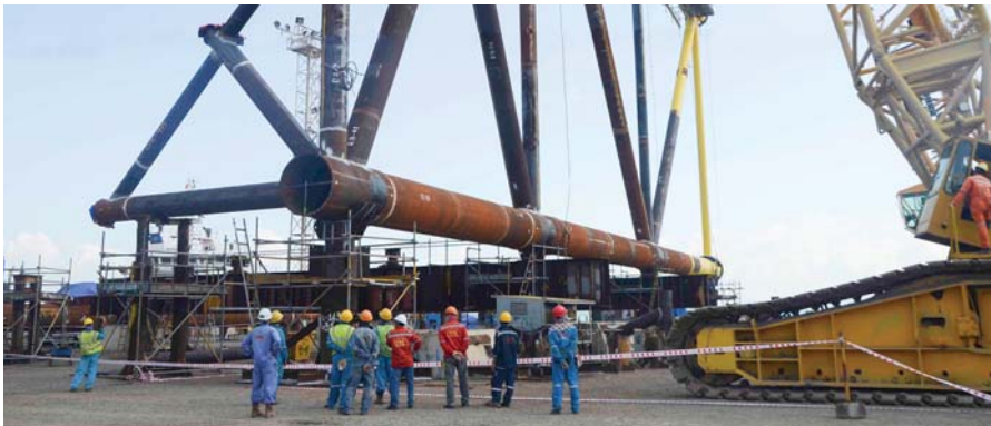
Panel Row B chân đế giàn Thỏ Trắng 3 được lắp dựng thành công. Ảnh: PVC
