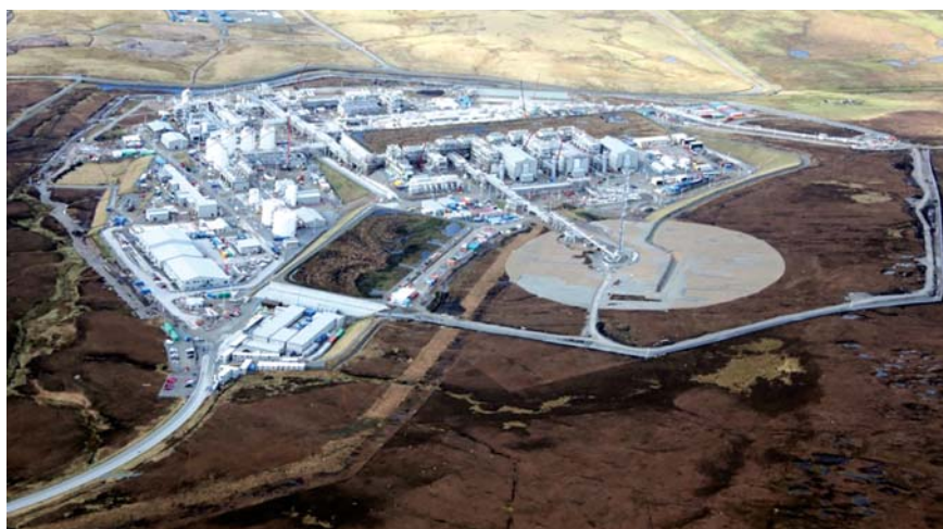
Nhà máy khí đốt Shetland xử lý khí khai thác từ cụm mỏ Laggan - Tormore. Nguồn: Total
