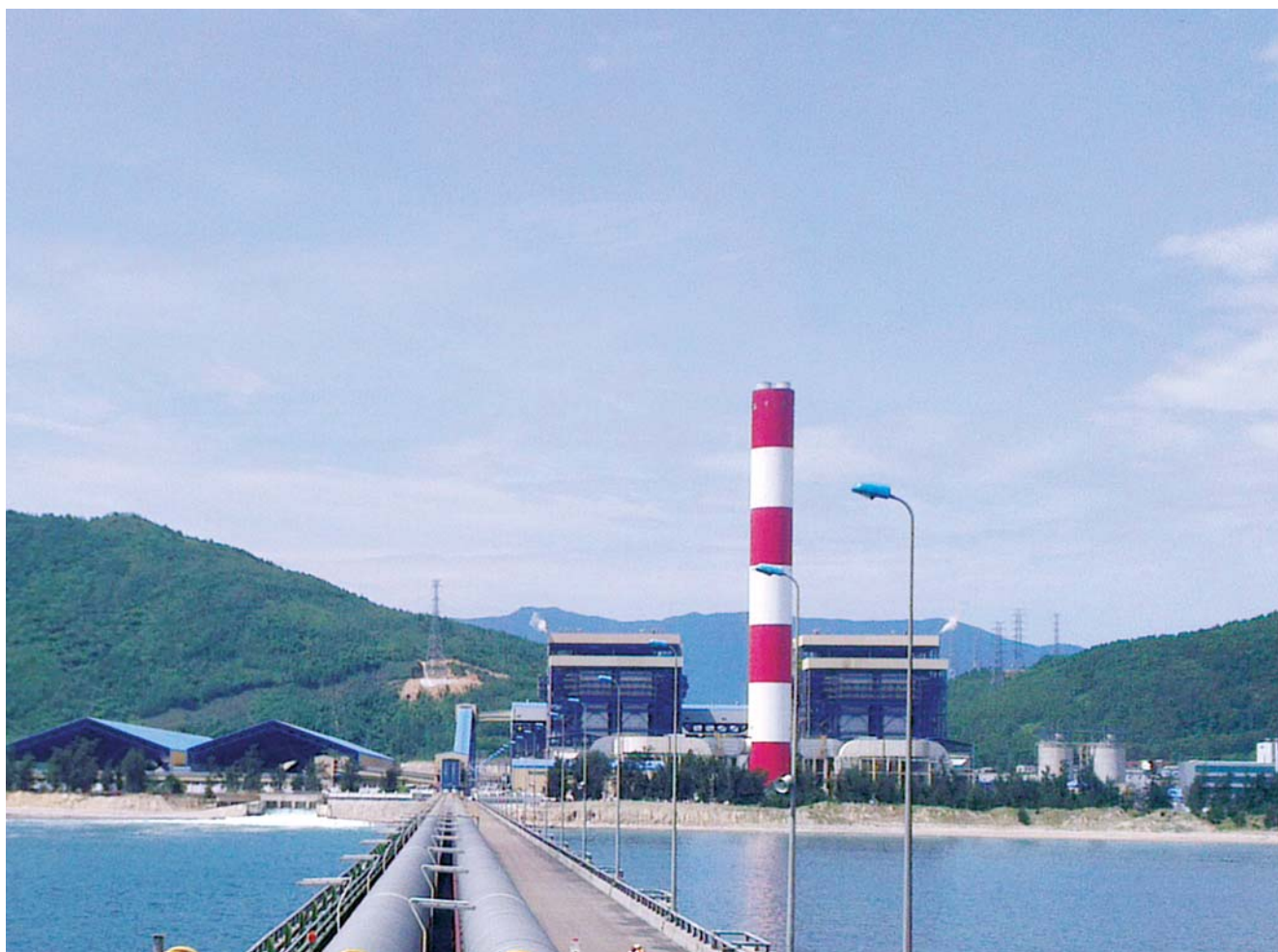
Nhà máy Nhiệt điện Vũng Áng 1. Ảnh: Duy Tinh
