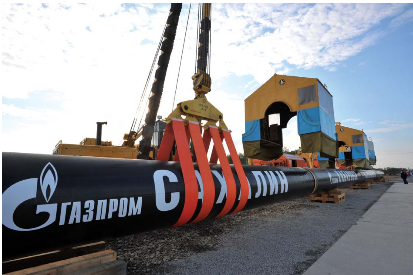
Lắp đặt đường ống dẫn khí Sakhalin-2. Ảnh: Gazprom
