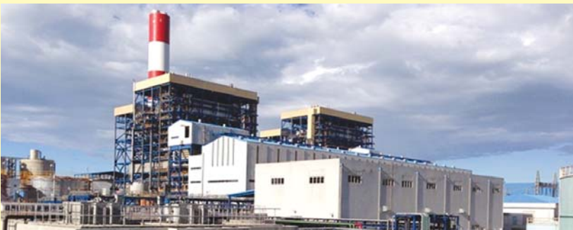
Nhà máy Nhiệt điện Vũng Áng 1. Ảnh: CTV
