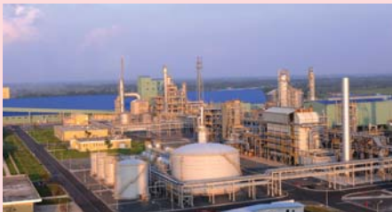
Nhà máy Đạm Cà Mau. Ảnh: PVCFC
