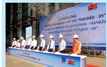
Các đại biểu bấm nút khởi công dự án Tam Đảo 05. Ảnh: VSP
