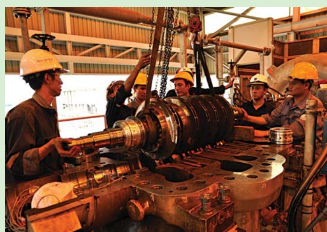
Các kỹ sư đang thực hiện công tác bảo dưỡng tại Nhà máy Đạm Phú Mỹ. Ảnh: DPM
