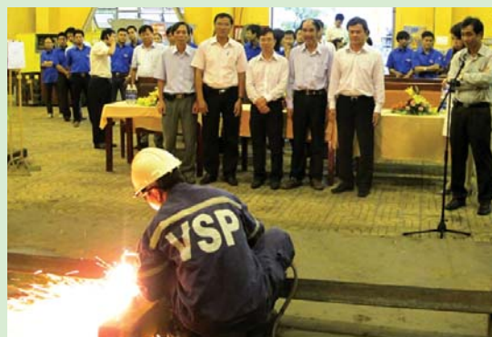
Nghi thức first cut khởi công chế tạo và lắp đặt gaslift BK-5 và BK-8. Ảnh: CTV
