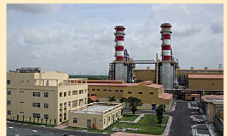
Nhà máy Điện Nhơn Trạch 2 cung cấp trên 4,2 tỷ kWh điện/năm. Ảnh: CTV
