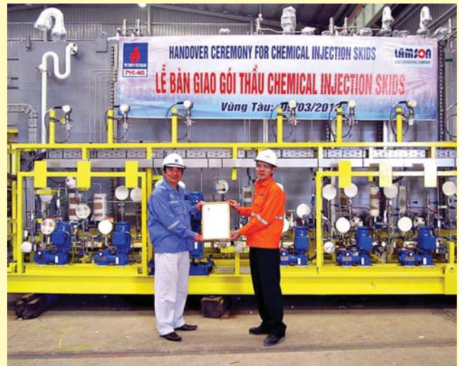
Dự án được Lam Son JOC nghiệm thu và đánh giá cao về chất lượng, đảm bảo tiến độ và tuyệt đối an toàn. Ảnh: PVC
