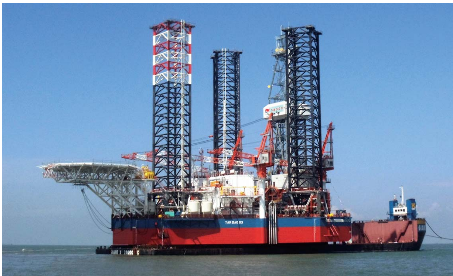
Giàn khoan 90m nước Tam Đảo 03. Ảnh: CTV
