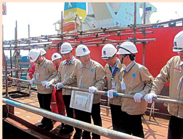
Đoàn công tác của PTSC trực tiếp kiểm tra công tác thi công dự án hoàn cải tạo FPSO PTSC Lam Sơn tại công trường. Ảnh: CTV
