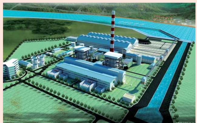
Phối cảnh mô hình Nhà máy Nhiệt điện Thái Bình 2. Ảnh: PVC
