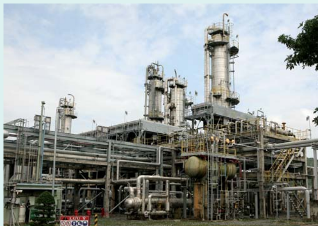
Nhà máy xử lý khí Dinh Cố. Ảnh: Lại Hiền
