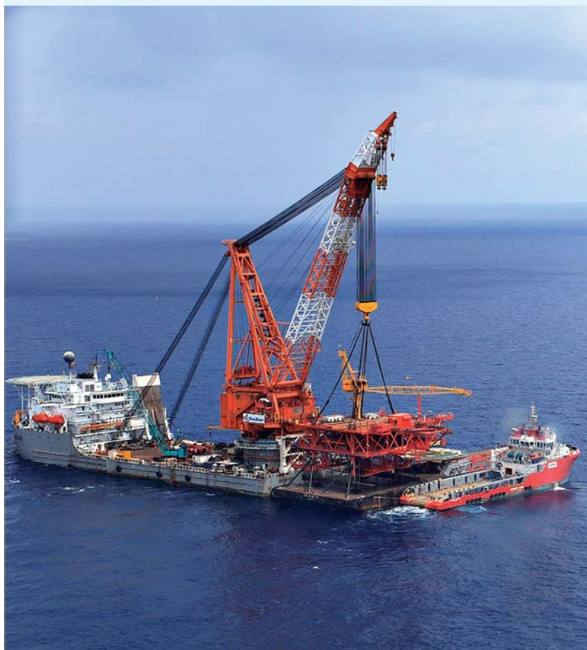
Lắp đặt chân đế Đại Hùng 02. Ảnh: CTV
