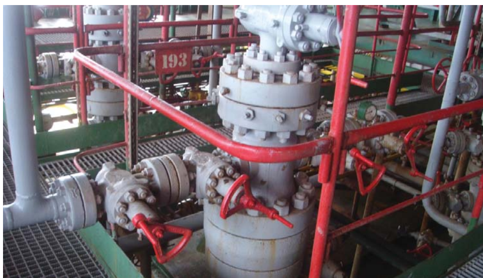
Hình 3. Đầu giếng OKK và AFK được thay bằng JKS có độ tin cậy cao hơn
