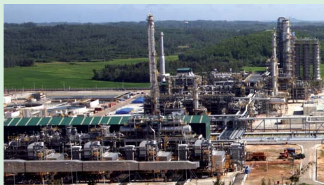
Phân xưởng công nghệ cracking xúc tác (RFCC) - phân xưởng công nghệ quan trọng nhất của NMLD Dung Quất. Ảnh: Ngọc Lâm
