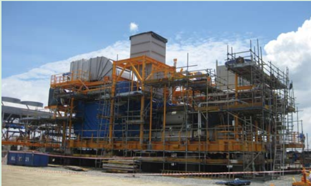
Hệ thống trạm máy nén khí (Booster Compressor) trên giàn Rồng Đồi do PTSC POS chế tạo. Ảnh: Đỗ Khánh
