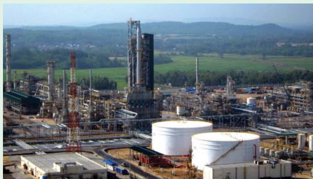
Dự kiến Tổ hợp nhà thầu Technip sẽ nghiệm thu lần cuối cùng và bàn giao NMLD Dung Quất cho BSR trong Quý III/2012. Ảnh: CTV
