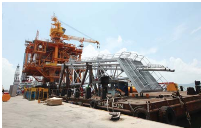
Chân đế, khối thượng tầng giàn khai thác Hải Sư Trắng đang được vận chuyển để lắp đặt, đầu nối ngoài khơi. Ảnh: Đỗ Khánh
