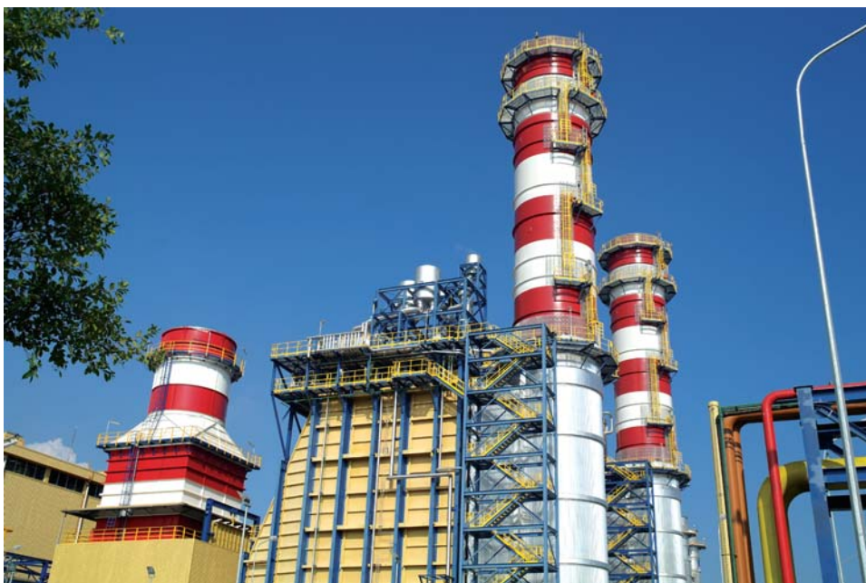
Một góc Nhà máy điện Nhơn Trạch 2. Ảnh: CTV
