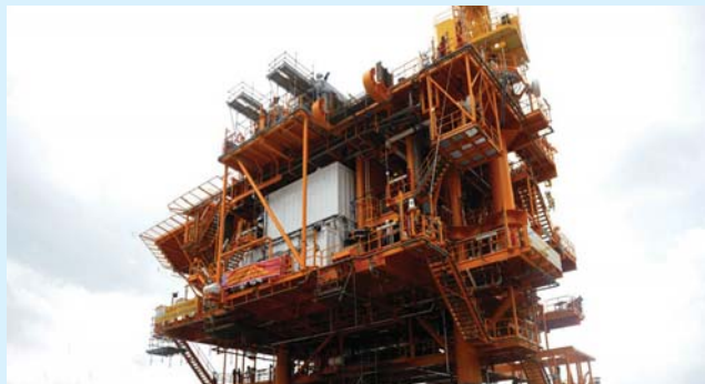
Dự án chân đế, khối thượng tầng giàn khai thác Sứ Tử Trắng được PTSC M&C triển khai đúng tiến độ, chất lượng, an toàn. Ảnh: PTSC
