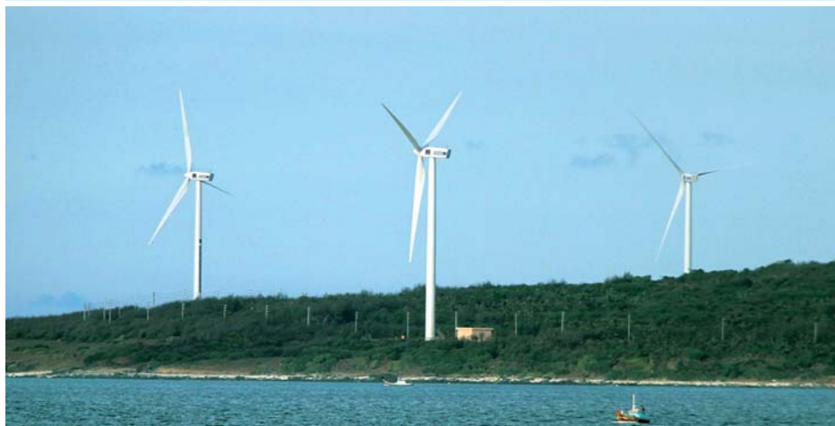
Dự án Phong điện Phú Quý dự kiến sẽ được đưa vào vận hành trong Quý II/2012. Ảnh: CTV
