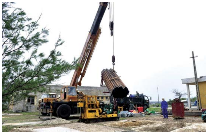
Lắp đặt thiết bị trên công trường khoan giếng ENRECA-3. Ảnh: Hoàng Tuấn
