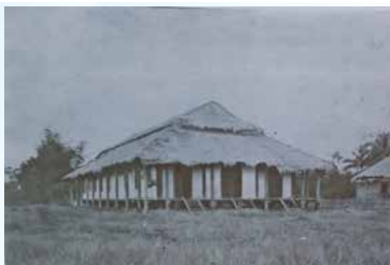
Nhà nguyện Kon Hring 1891. Ảnh: MEP
