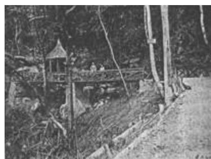
Cầu trên đoạn đường Đăn - Trạm Hành
