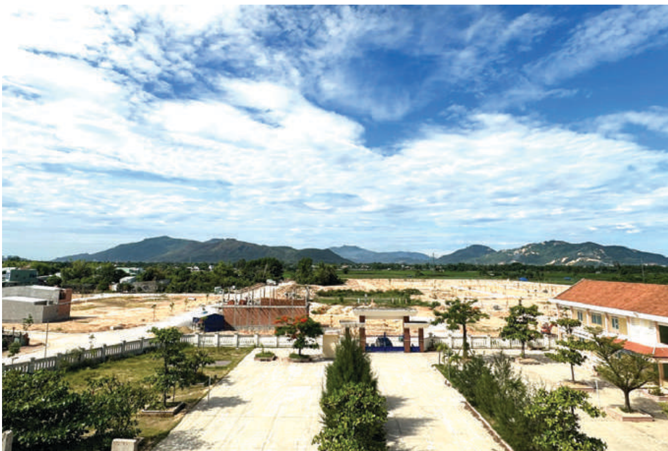
Cơ sở hạ tầng khu Tây Nam thị trấn Tuy Phước
