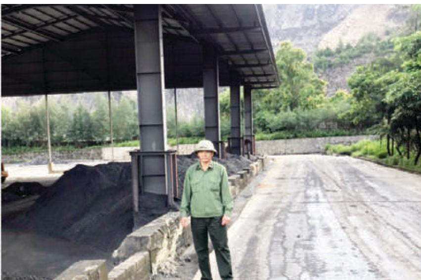
Kiểm soát bãi chứa than MB+110 Công ty Than Thống Nhất
