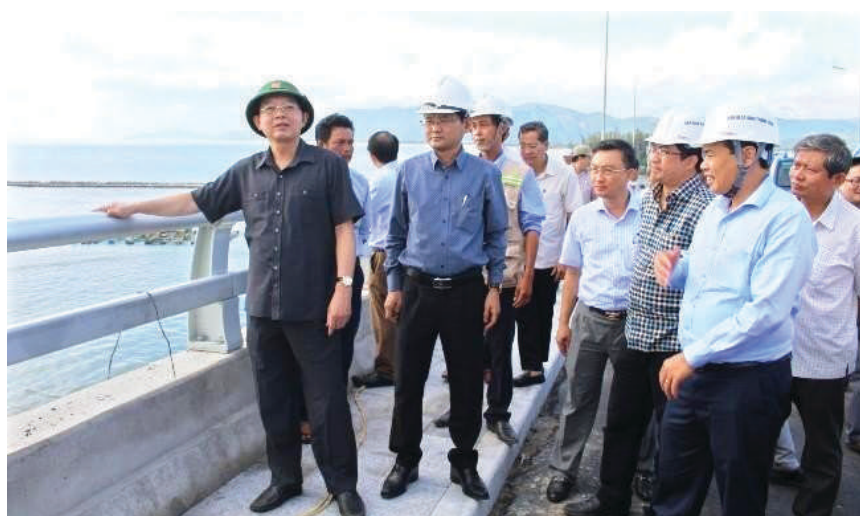
Bí thư Tỉnh ủy Hồ Quốc Dũng (ngoài cùng bên trái) và Phó chủ tịch UBND tỉnh Nguyễn Tự Công Hoàng (thứ 2 tính từ trái qua) cùng đoàn công tác đi kiểm tra hiện trường dự án Tuyến đường ven biển (ĐT.639), đoạn Đề Gi - Mỹ Thành
