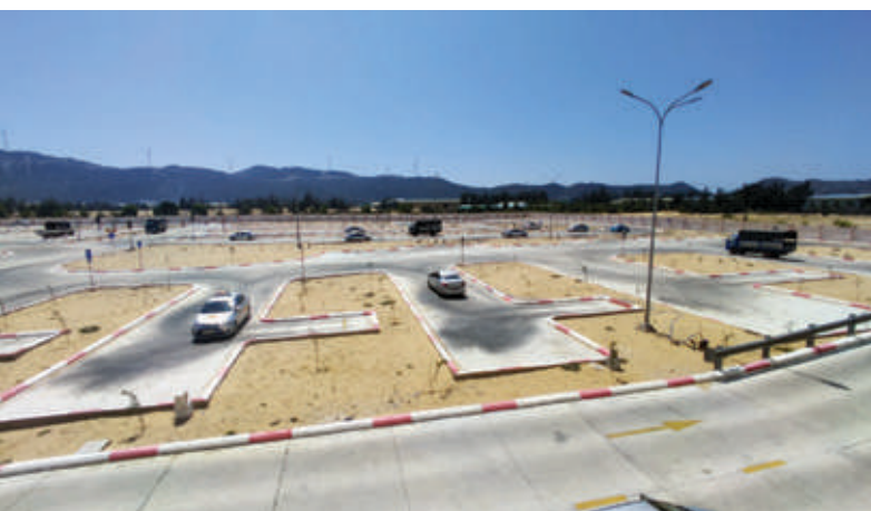
Thực hiện công tác bảo dưỡng xe ô tô đảm bảo tình trạng kỹ thuật, phục vụ đào tạo và sát hạch
