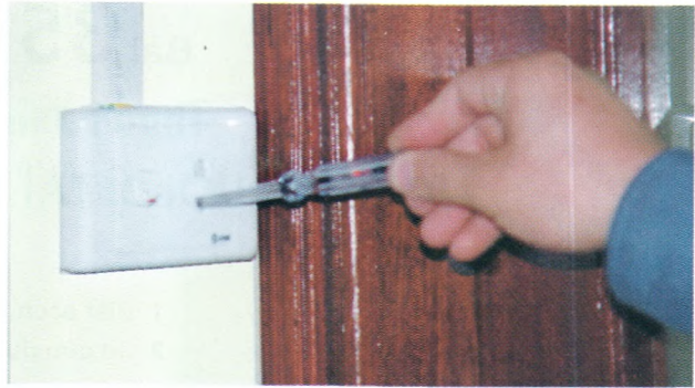
Hình 34.2. Sử dụng bút thử điện để xác định dây pha của mạch điện
