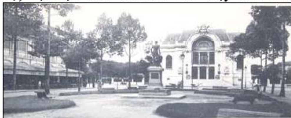
Công trường Nhà Hát khoảng (1905)
