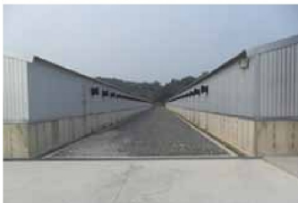
Hình 5: Đồ bê tông xung quanh trại giúp dễ vệ sinh sát trùng.
